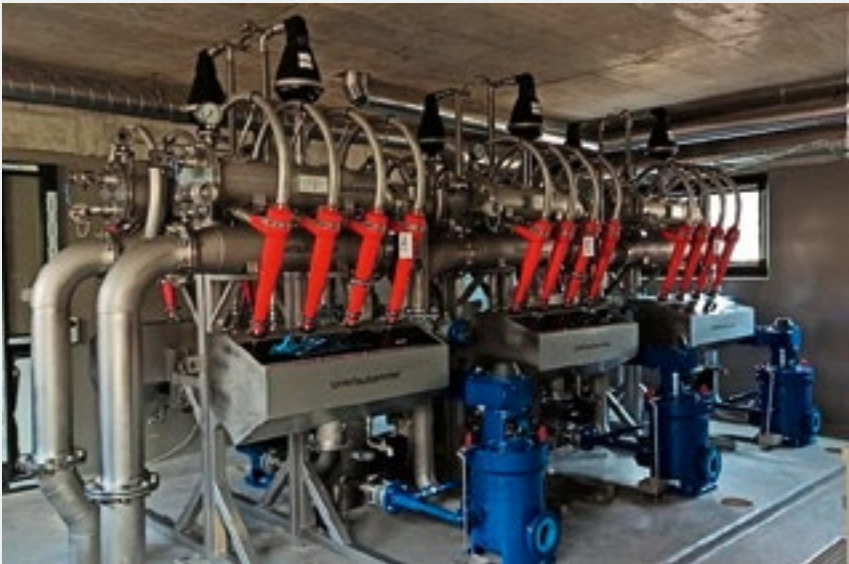
Fig. 5 Hydrozyklon des S::Select-Verfahren mit granulärem Schlamm.
